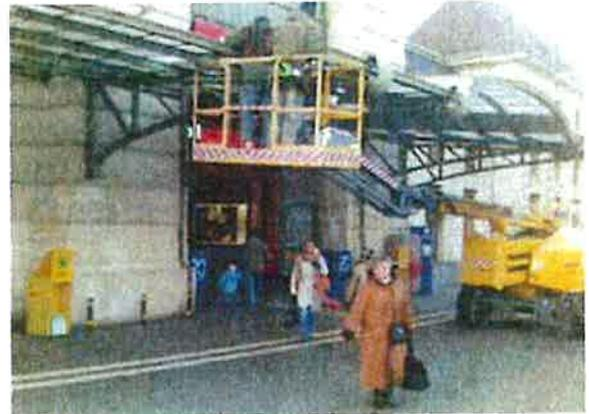
Figura 19. Personas circulando bajo la vertical de una PEMP sin balizar
