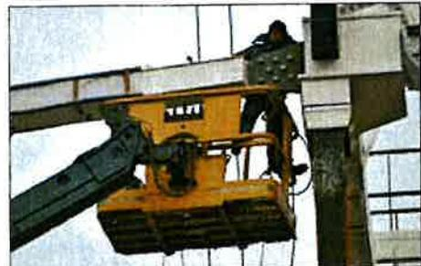
Figura 19. Operario subido sobre las barandillas.
