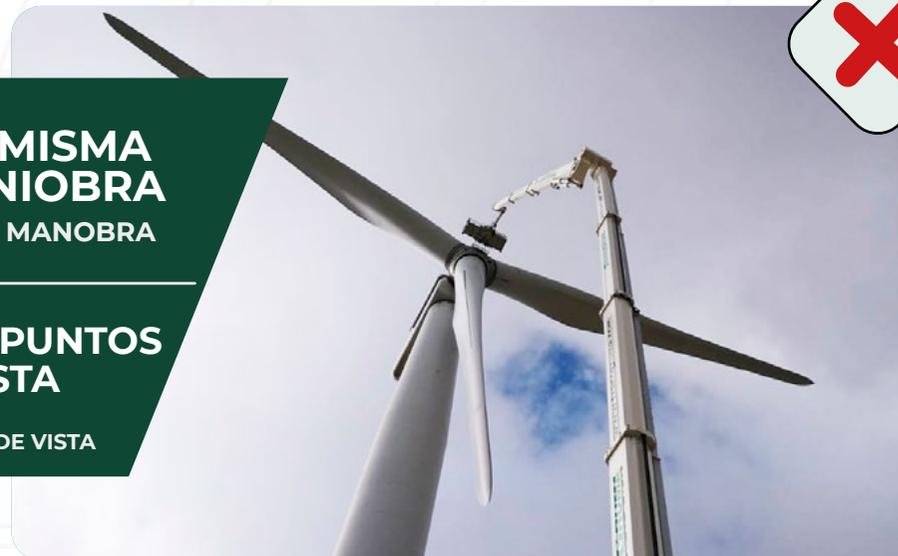
EL CONTROL DE LA MANIOBRA POR OPERADOR DESDE LA PLATAFORMA DE TRABAJO PERMITE UNA VISIBILIDAD PERMANENTE, CONTINUA Y CERCANA DE LA MANIOBRA, LO QUE GARANTIZA LA SEGURIDAD EN EL SERVICIO.
